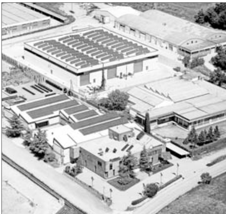
L'empresa ha instal·lat plaques solars a la seva teulada
